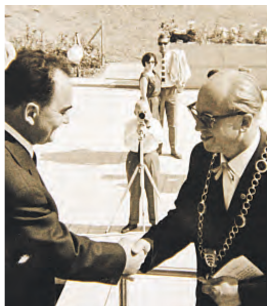
Erwin Spier (links) mit Oberbürgermeister Arthur Gruber bei der Einweihung am 27. Juni 1964
